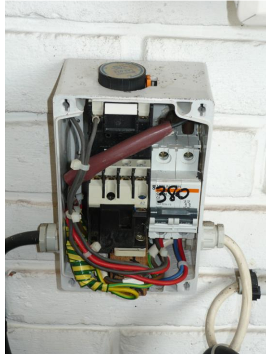
Photos 7 et 8. Boîtier de commande de l'électrovanne. A l'intérieur du boîtier, de gauche à droite : le contacteur surmonté de sa tête de temporisation, et le disjoncteur de protection de bobine et d'électrovanne.
