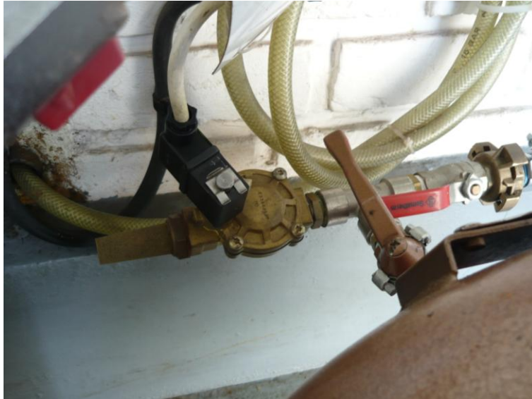
Photo 6. Electrovanne à membrane. En bout d'électrovanne on peut apercevoir son silencieux d'échappement : cône en bronze fritté.
